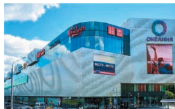
ТРЦ «Океания» г. Москва, Кутузовский проспект, д. 57 Общая площадь: 135 041,8 кв. м
