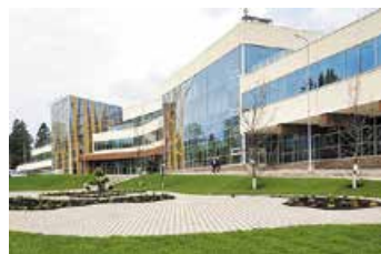
Институт ядерной медицины (АО «Медицина») Амбулаторно-диагностический комплекс и Комплекс Радионуклидного Обеспечения Общая площадь: 22 000 кв.м. Техническая эксплуатация
