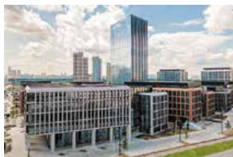
Бизнес-Парк «Ростех-Сити» Общая площадь: 263 200 м 2 Управление и эксплуатация объекта г. Москва, Волоколамское шоссе, 75А
