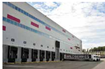
Складской комплекс Wildberries Тула 200 000 кв.м
