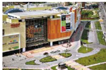
ТРЦ АУРА г. Новосибирск Общая площадь: 150 085 м 2 Услуги: Комплексное техническое обслуживание инженерных систем и оборудования
