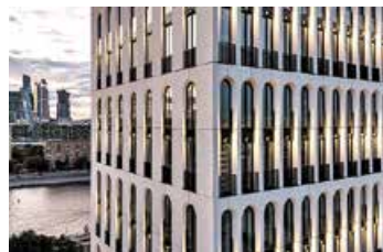
Клубный дом BRODSKY г. Москва, 1-ый Тружеников пер., д. 16. Предэксплуатация, эксплуатация и комплексное управление объектом с 2021 года.
