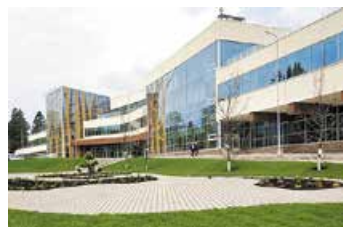
Институт ядерной медицины (АО «Медицина») Амбулаторно-диагностический комплекс и Комплекс Радионуклидного Обеспечения Общая площадь: 22 000 кв.м. Техническая эксплуатация
